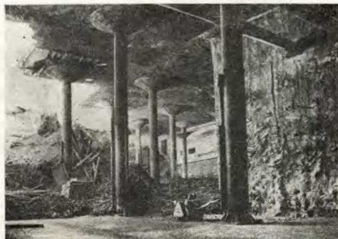
Рис. 4. Опорные колонны перекрытия.
