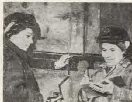
Проходчица Е. Уварова и сменный маркшейдер В. Дадылбаева [СМУ-13] измеряют зазор узла расжатия в обделке переходного тоннеля.
