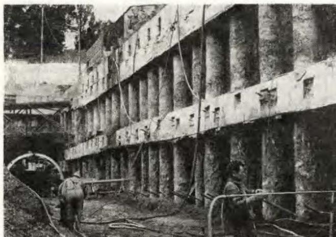
Рис. 4. Свайная стена в натуре.
