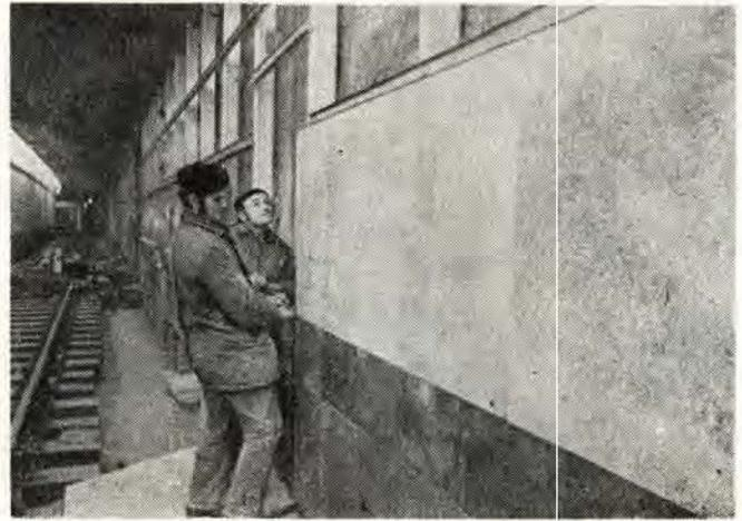
**Рис. 2. Монтаж мраморных плит.**
