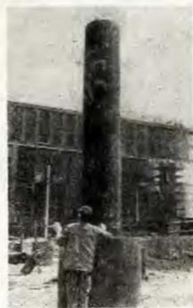
Рис. 3. Опускание колонны в закрепленную скважину.
