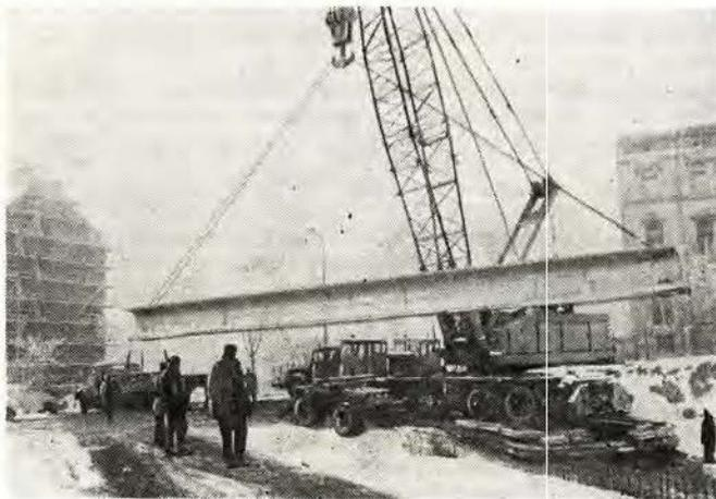
Рис. 6. Укладка балок с помощью передвижающегося крана.
