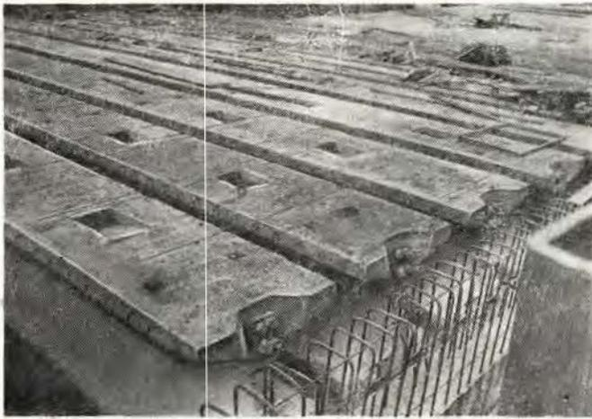
Рис. 8. Установка балок (армирование замыкающей стенки).
