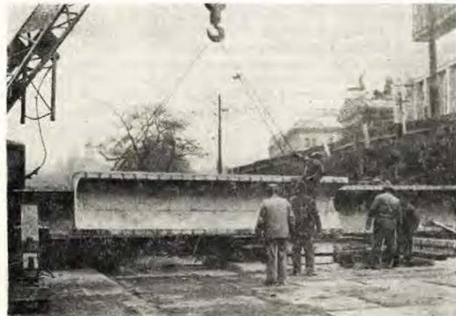
Рис. 3. Монтаж балок из предварительно напряженных секций.
