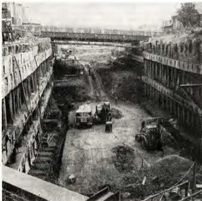
Рис. 3. Котлован с закрепленными стенами.
