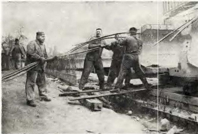
Рис. 4. Нанизывание кабелей для предварительного напряжения.
