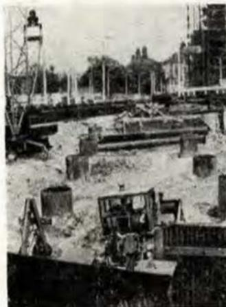
Рис. 2. Установка обсадных труб в скважинах для колонн.
