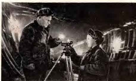
Маркшейдеры СМУ-7: ветеран Метростроя А. Попов и Р. Якубова проверяют направление трассы между станциями «Новокузнецкая» и «Площадь Ногина».
