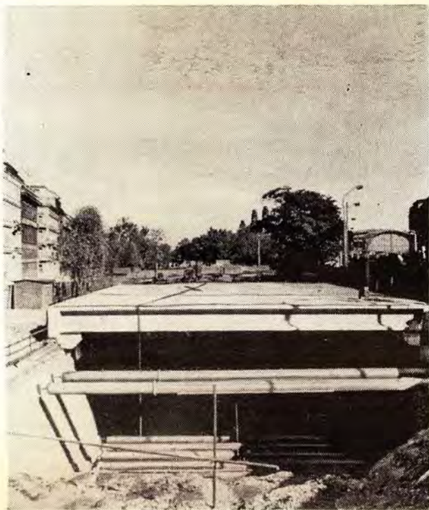
Строится станция «Музей».
