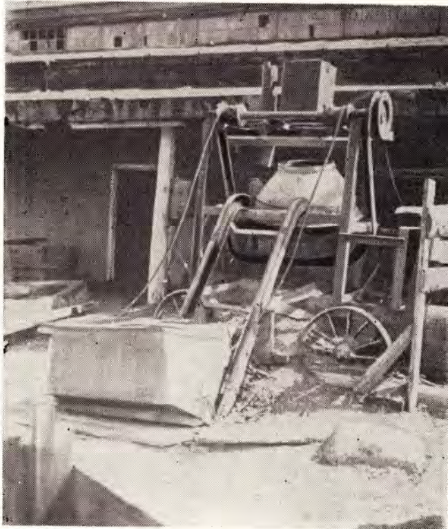
Так кустарно изготавливались раньше железобетонные блоки.
