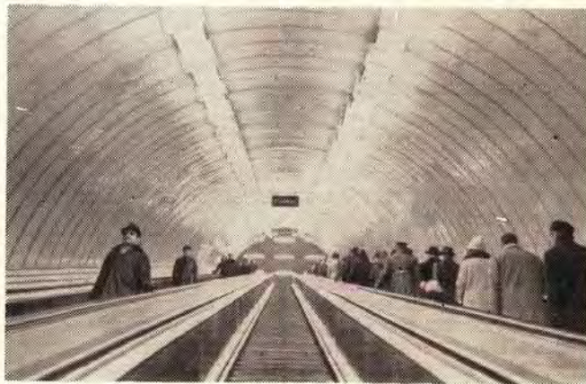
Наклонный тоннель к ст. «Площадь Бароша» со сводом, выполненным из пластика.
