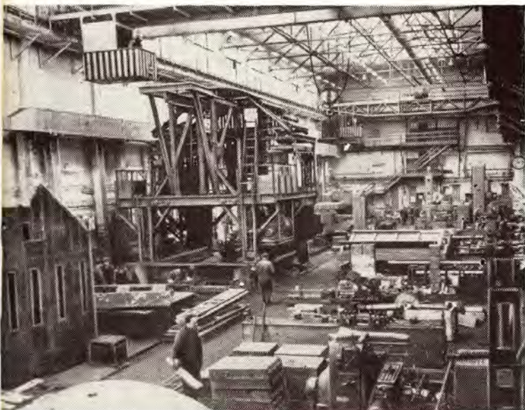
Механосборочный цех. Монтируется станционный блокоукладчик.
