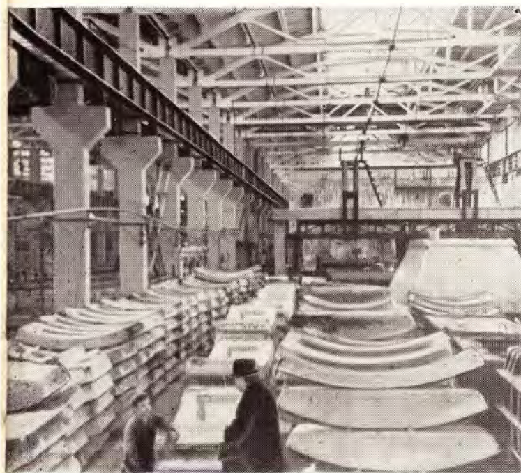
Современный цех железобетонных тубингов.
