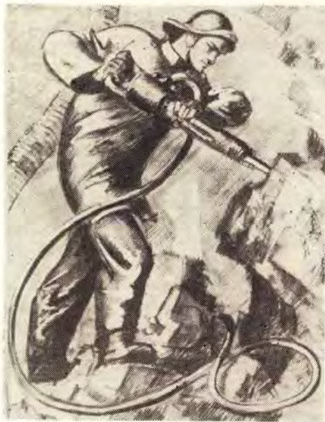
На рисунке художника В. Хвостенко проходческие процессы отбойки породы на строительстве 1 очереди.
