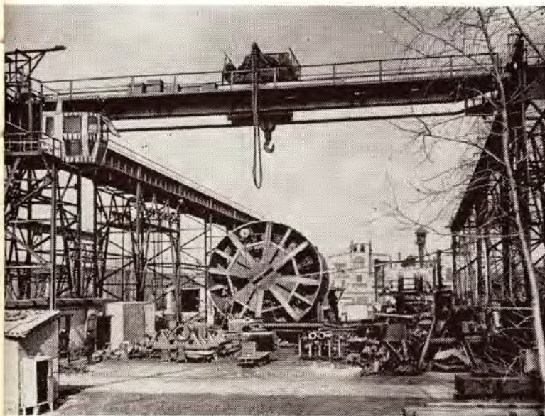
Открытая эстакада. Заканчивается изготовление механизированного щита Д-8,5 м для сооружения ж.-д. тоннеля
