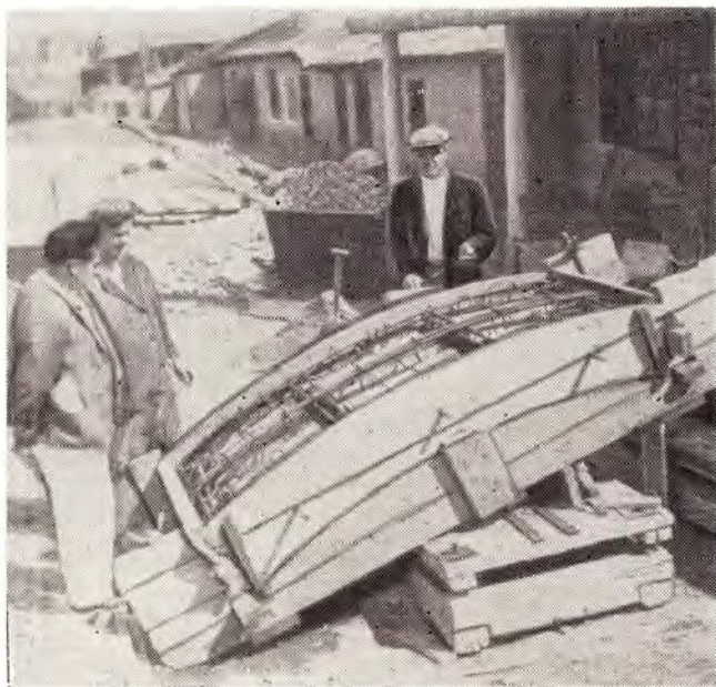
Так кустарно изготавливались раньше железобетонные блоки.
