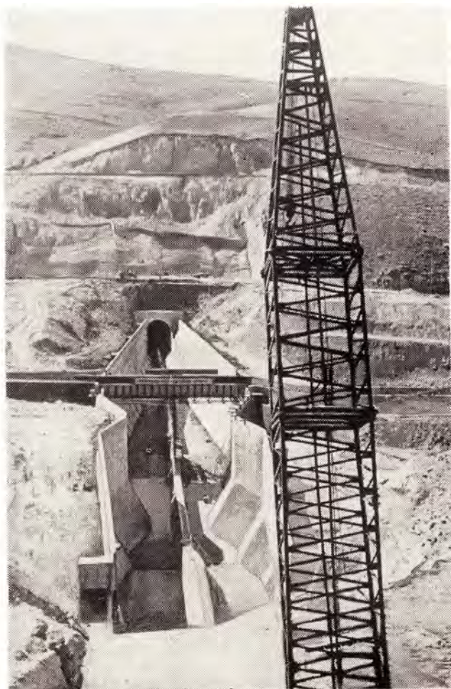
Гидротехническое сооружение по отводу русла реки Ангрэн.
