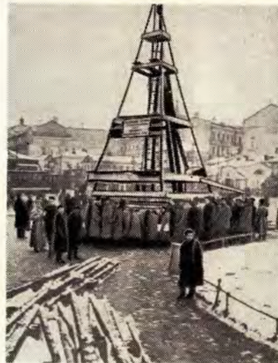
Так начиналась подготовка к строительству метрополитена. На снимке: бурение скважины на одной из площадей города для определения инженерно-геологических условий трассы.
