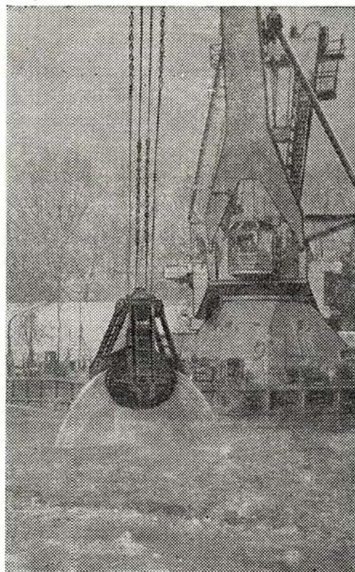
Разработка выемки в русле канала грейфером
