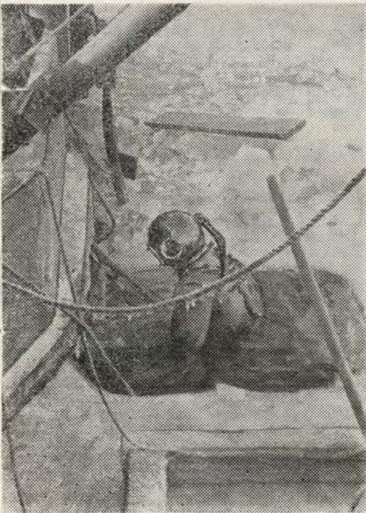
Спуск водолаза для контроля правильности установки секций
