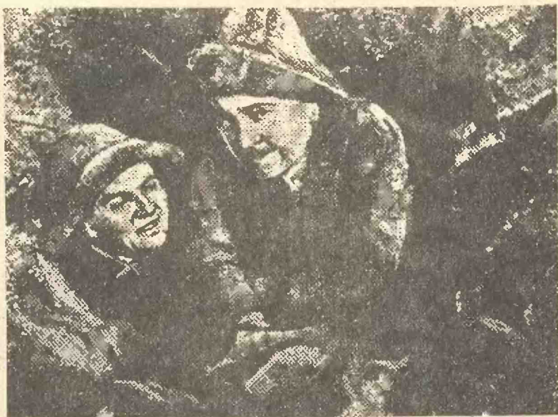
С.Н. Розанов и Е.Т. Абакумов в тоннельной выработке.
