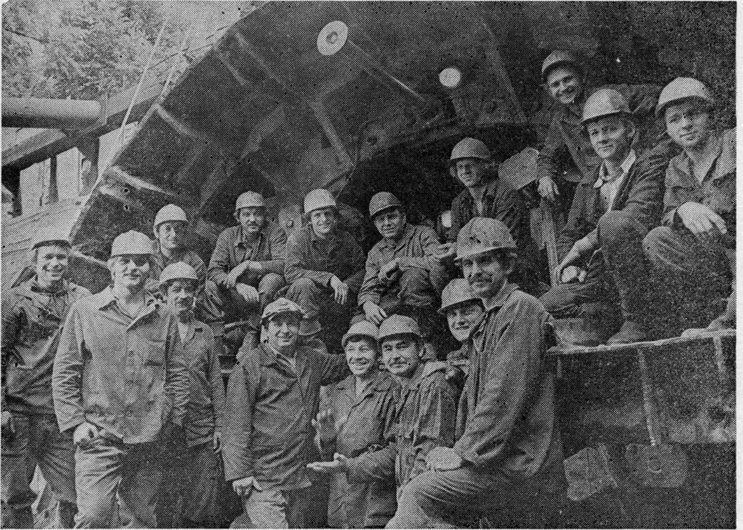
Бригада П. Тихомирова, досрочно завершившая проходку подводных перегонных тоннелей.
