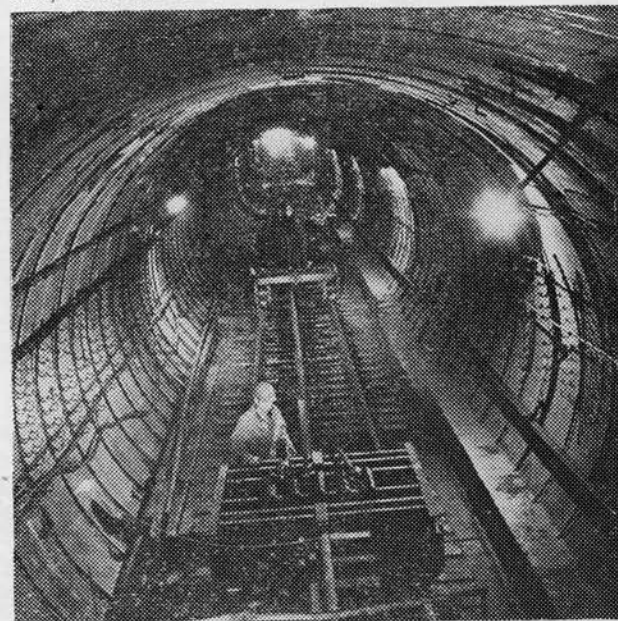
Бригада путейцев Тоннельного отряда № 1, возглавляемая Ю. Барабашем, ведет монтаж верхнего строения пути.
