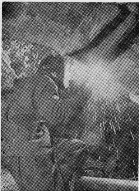
Вырезка рельсов фундамента старого моста.
