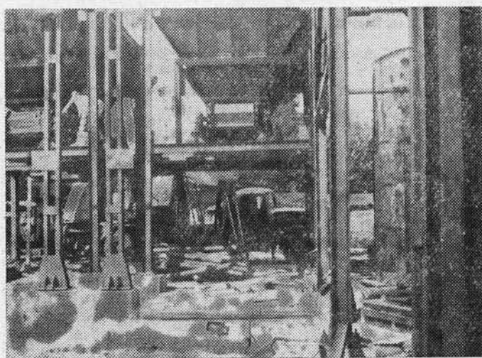
Монтаж бункеров эстакады
