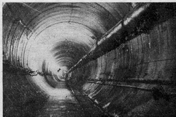
Тоннель с монолитно-прессованной бетонной отделкой, пройденный комбайном ТЩБ-7 между «Нахимовским проспектом» и «Севастопольской».
