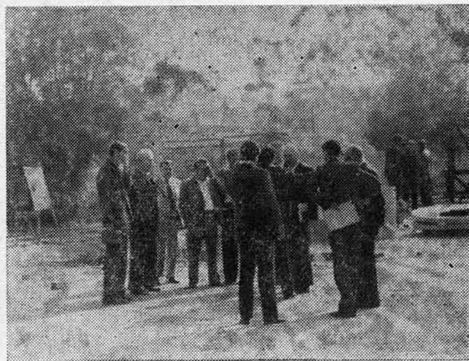
Штаб стройки вместе с подрядчиками проверяет строительство прирельсовой базы.
