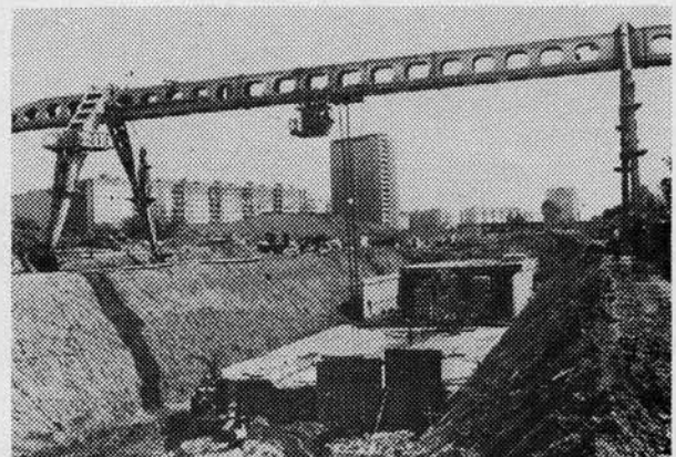
Стройплощадка станции «Орехово».
