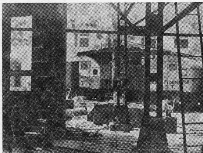
Передвижные замораживающие установки. На втором плане — здание душкобината.
