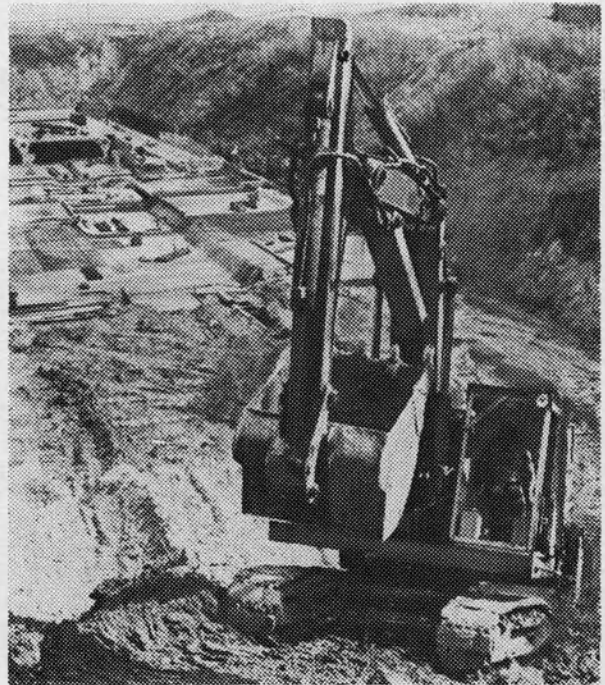
На месте будущей станции «Красногвардейская».
