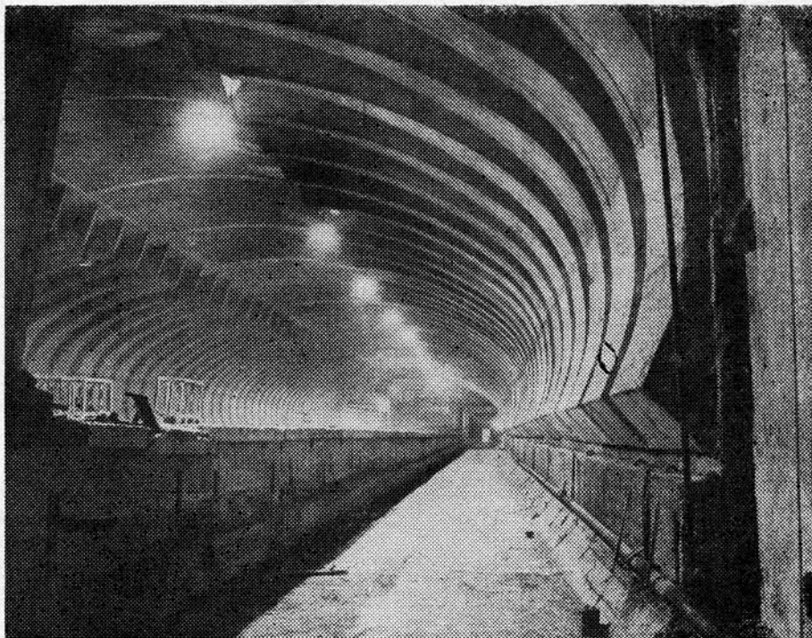
Строится станция «Ленинская» Горьковского метрополитена.
