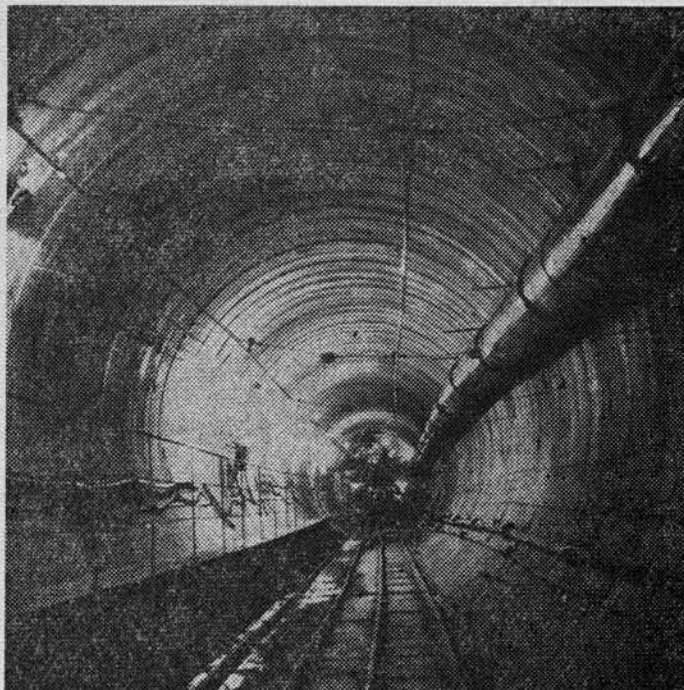
Перегонный тоннель в монолитно-прессованной бетонной оболочке на строящемся Серпуховском радиусе метро в Москве.
