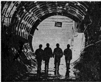
Левый тоннель между станциями «Институт культуры» и «Площадь Ленина» Минского метрополитена пройден под железнодорожными путями.
