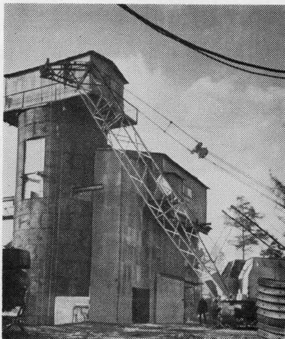
Горный комплекс на продлеваемом Замоскворецком радиусе (СМУ № 10 Мосметростроя).
