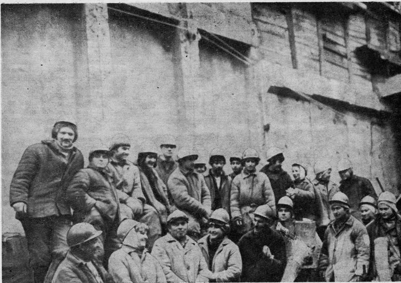
Комсомольско-молодежная комплексная бригада А. Акимова (СМУ № 3 Мосметростроя) забетонировала свод станции «Южная» менее чем за два месяца. Работы вели по скользящему графику с применением инвентарной передвижной металлической опалубки стен и свода.
