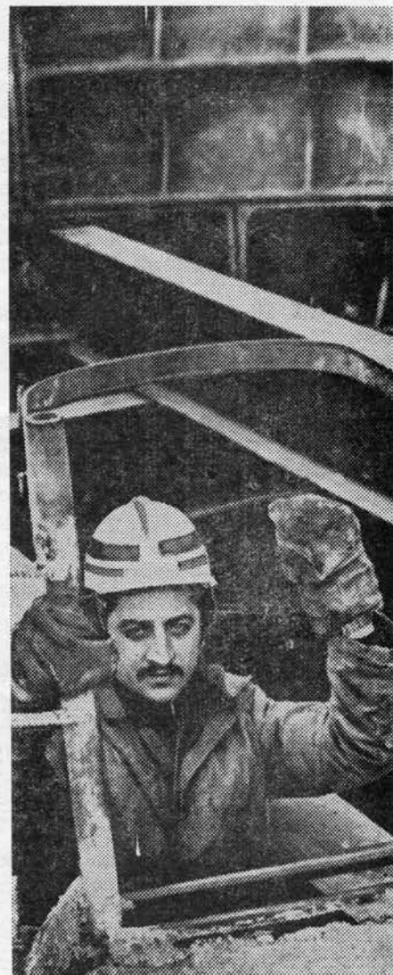
Проходчик В. Моисеев укрепил последний тубинг ствола.
