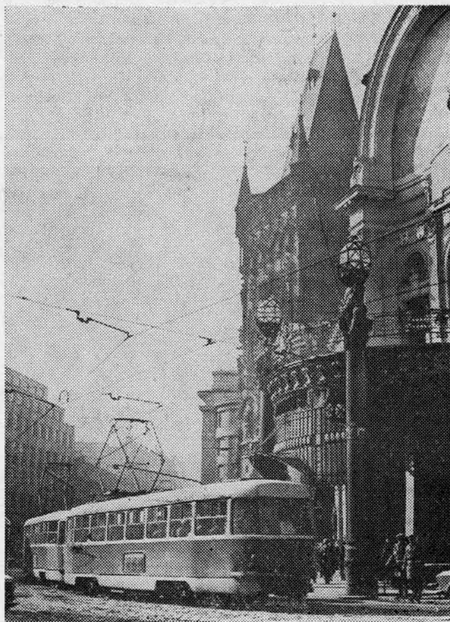
Близ Пороховой башни в центре Праги идет проходка тоннелей линии IV.
