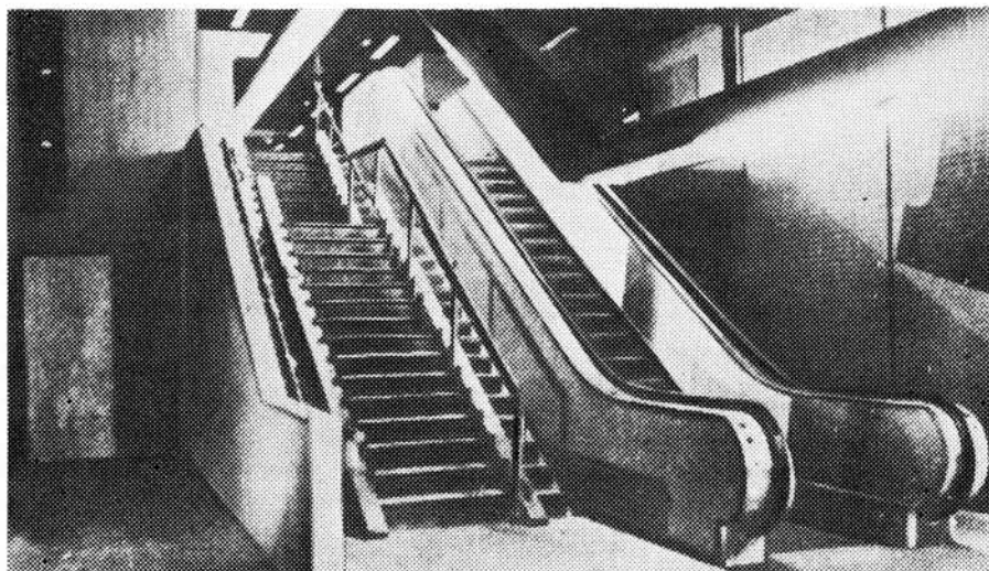
Подъемные устройства: лифт для пожилых и инвалидов, лестница и эскалатор
