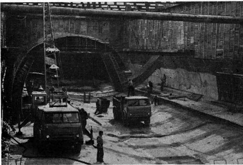
Момент строительства оборотного съезда ст. «Пахтакор»
