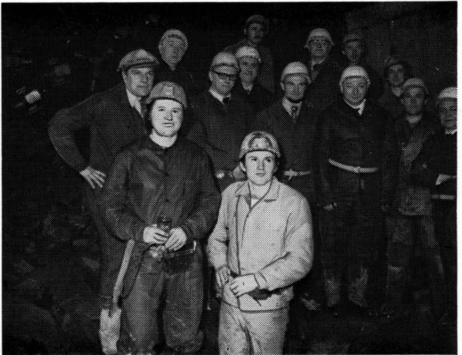
Чехословацкие и советские специалисты после завершения проходки перегонного тоннеля механизированным щитовым комплексом с монолитно-прессованной обделкой
