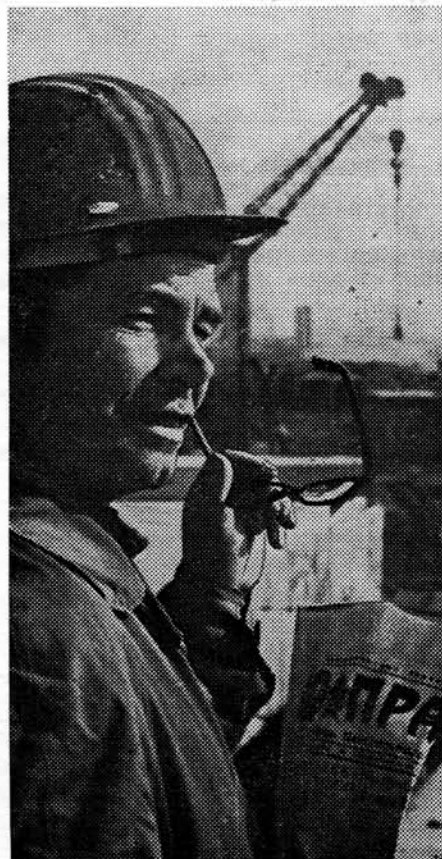
Один из лучших агитаторов на Метрострое коммунист С. Ходыров работает звеньевым проходчиков на перегоне «Медведково» — «Бабушкинская».
