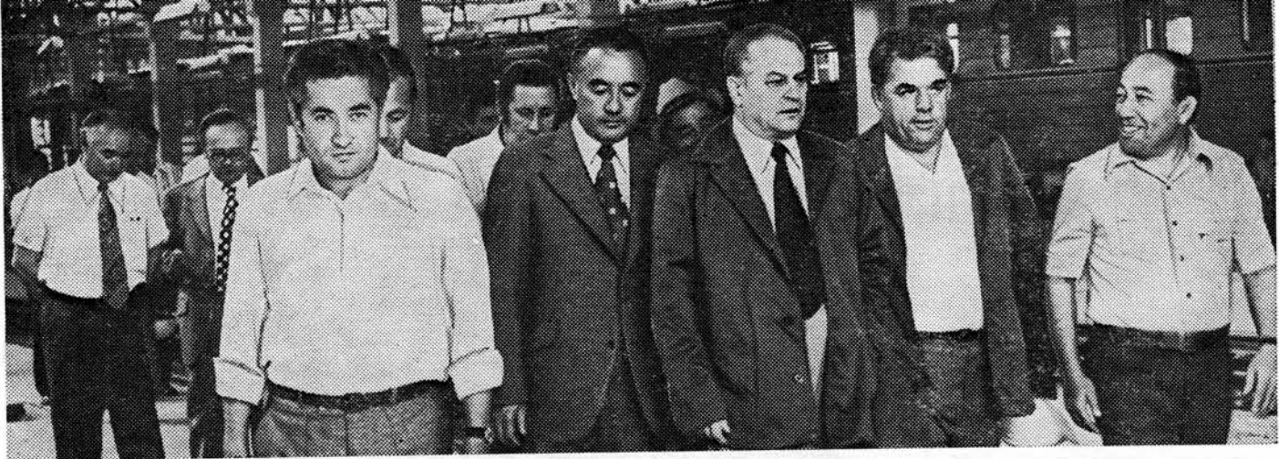
Посещение строительства Ташкентского метрополитена Министром транспортного строительства СССР И. Д. Сосновым
