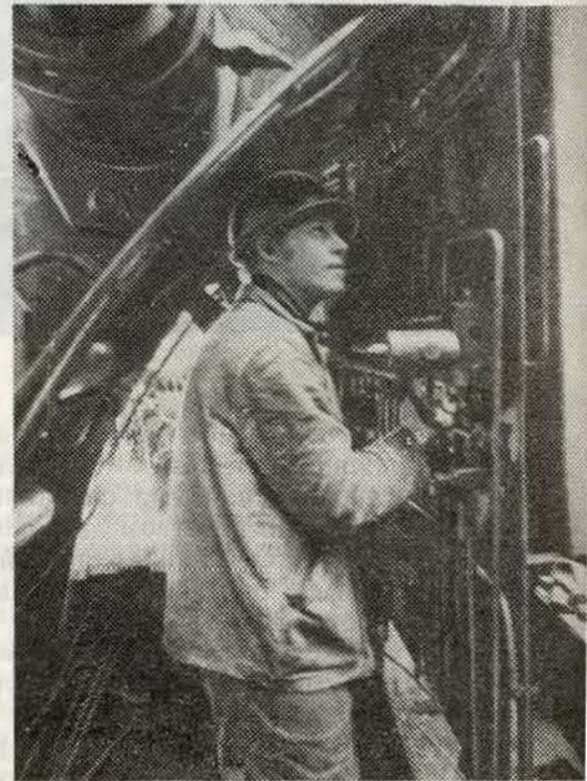
Машинист В. Медведев за пультом управления агрегатом по продавливанию тоннеля под железнодорожными путями
