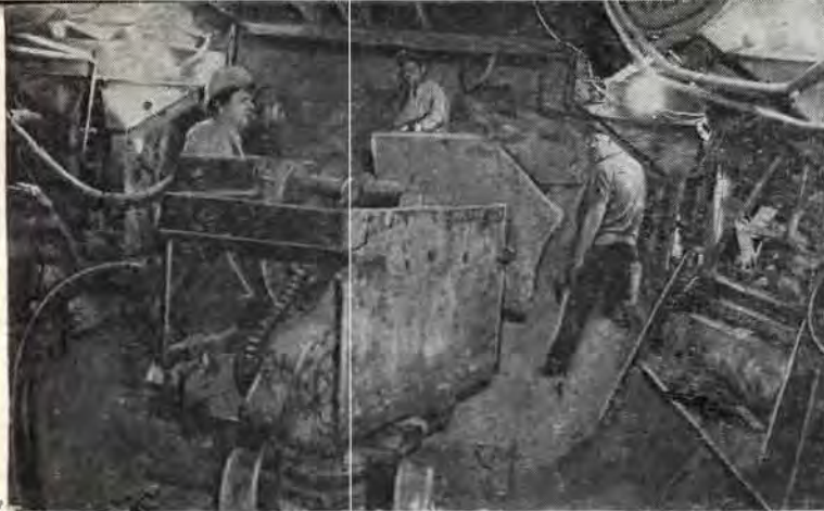
Проходка левого тоннеля ветки в дело
