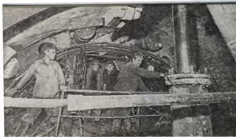
Монтаж кольца в момент соревнования за звание «Лучшая бригада проходчиков»
