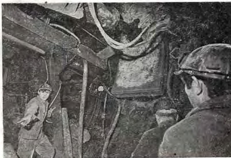
Монтаж кольца железобетонной обделки на перегоне «Проект Гагарина» — «Спортивная»
