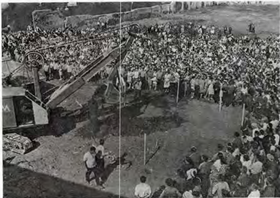
15 июля 1968 года. Первый новш на трассе первой очереди Харьковского метрополитена
