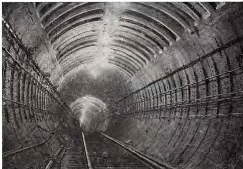
Перегонный тоннель между станциями «Ул. Свердлова» — «Южный вокзал»
