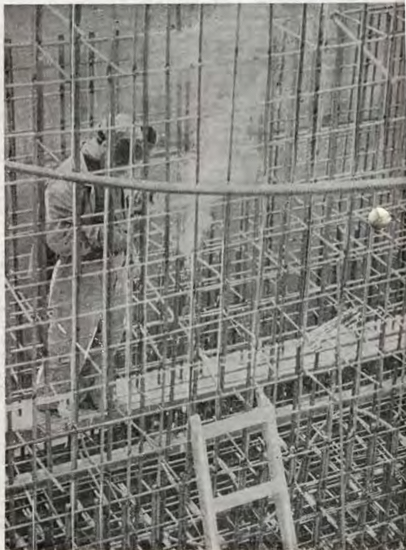
Монтаж каркаса входа на ст. «Спорти
