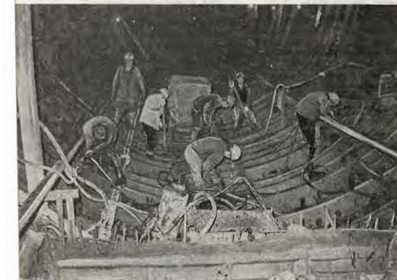
Очистка и чеканка лотка среднего тоннеля станции «Южный вонзал»
