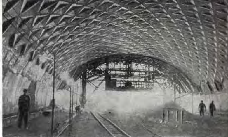
Перестановка опалубки на строительстве одноводчатой станции «Спортивная»
