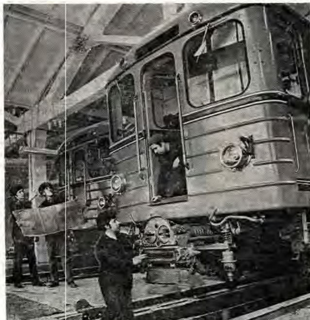
Депо Харьковского метрополитена. Идет подготовка подвижного состава к эксплуатации
