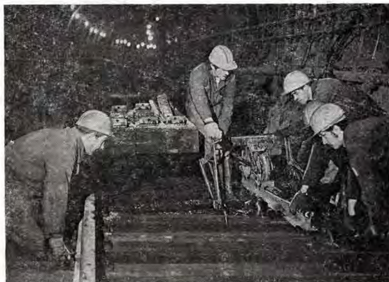
Бригада Н. Сидякина на укладке путей в правом перегонном тоннеле между станциями «Пр. Гагарина» — «Спортивная»
