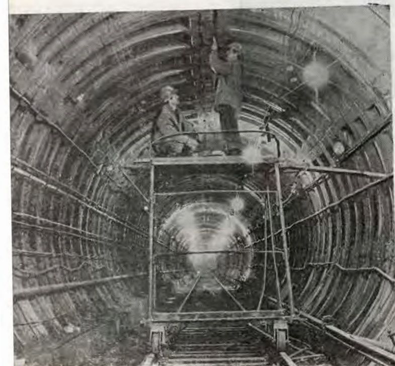
Гидроизоляционные работы на перегоне правого тоннеля ст. «Проспект Гагарина» — «Советская»
