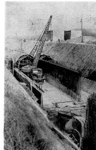
Сооружение сборно-монолитного участка перегона
