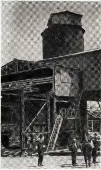
На станции «Баренамутян» закончен монтаж горного комплекса и сдан в эксплуатацию клетевой подъем
