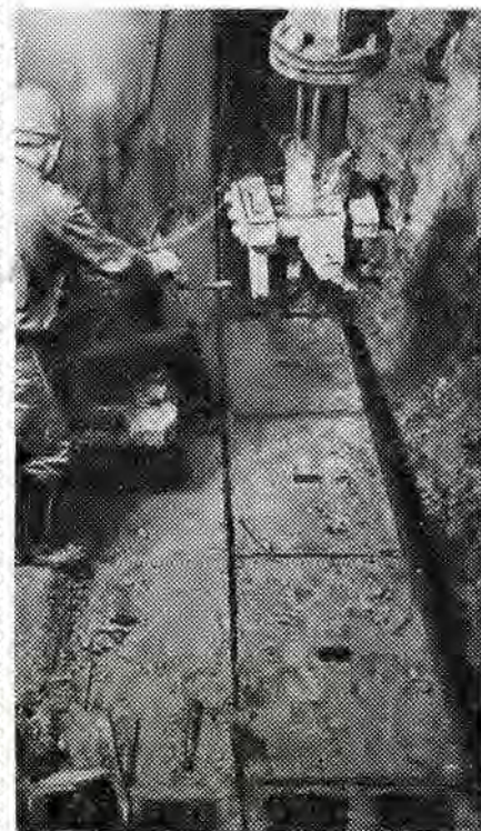
Установка плоского чугуно-бетонного станционного лотка на «Площади Пушкина»
