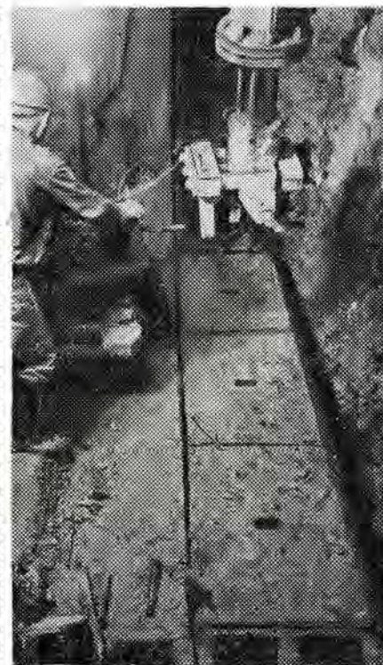
Установка плоского чугуно-бетонного станционного лотка на «Площадь Пушкина»
