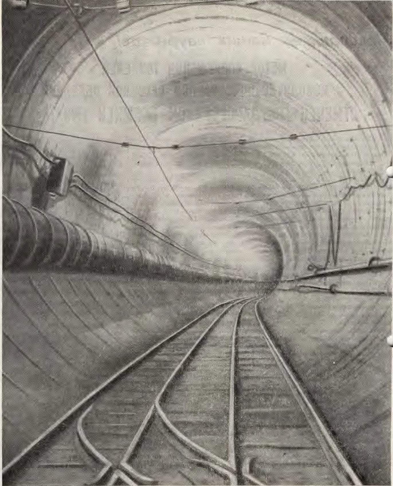
Тоннель с обделкой из монолитно-прессованного бетона, проложенный в песках на участке Краснопресненского радиуса в направлении станции «Щунинская».
