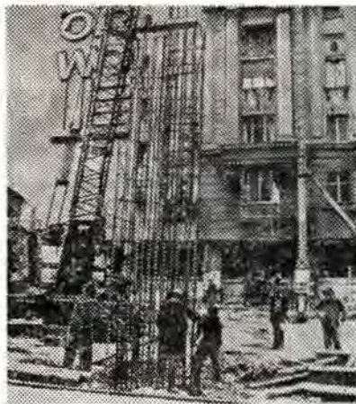
Установка арматурных каркасов краном
