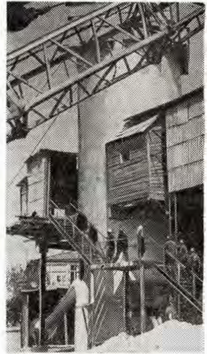
Шахтный копер на станции «Киевляны»
