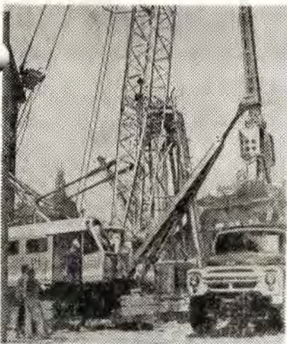
Установка для бурения на строительной площадке
