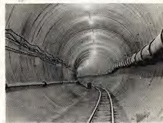
На снимках (сверху вниз): щит для сооружения тоннелей с монолитно-прессованной бетонной обделкой; бетоноводы; тоннель Тбилисского метрополитена с монолитно-прессованной обделкой.
