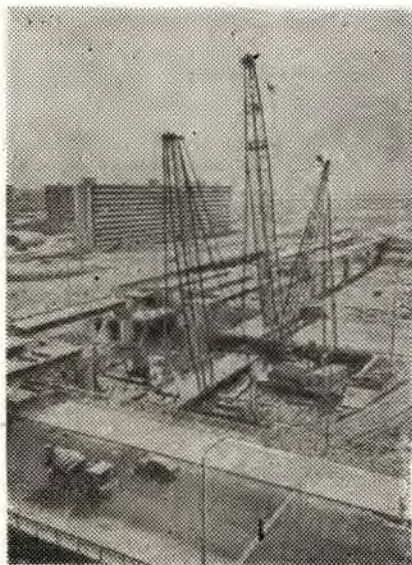
Строится метро в Амстердаме.
