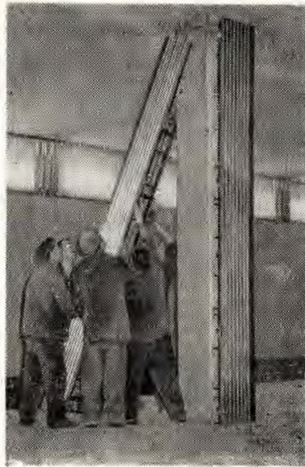
Рис. 4. Монтаж панелей облицовки.
