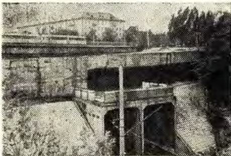
Тоннель метро, сооруженный над железнодорожным полотном.
