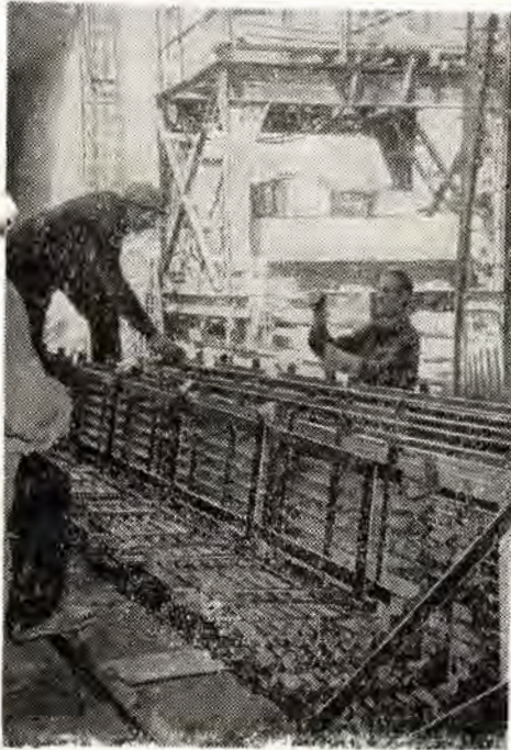
Рис. 2. Транспортировка заготовлен­ных элементов в специальном конте­й­нере на место монтажа.
