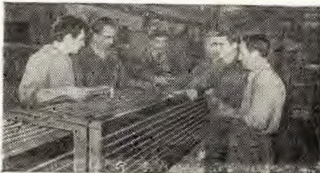
Рис. 3. Бригада слесарей В. Иванюка закончила облицовку колонны
