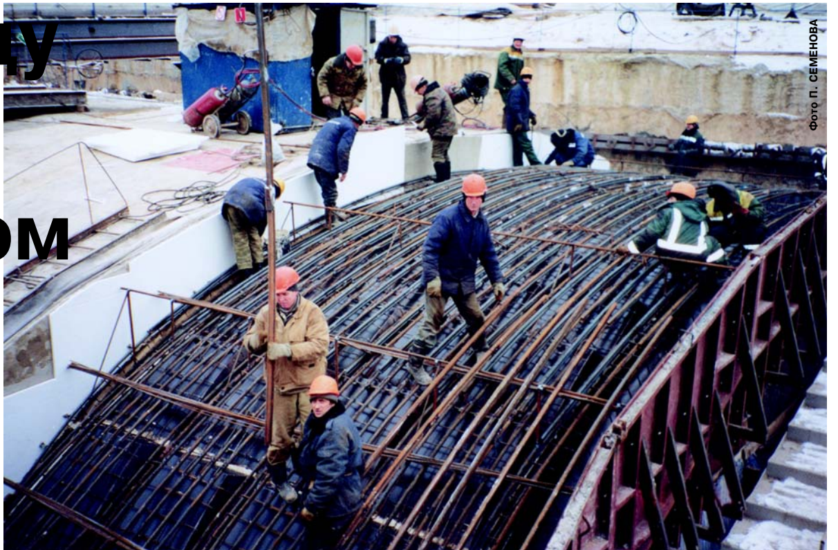
Рождение арматурного каркаса.
