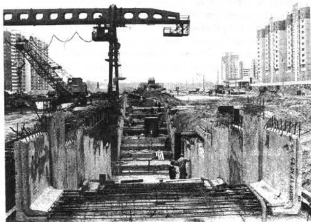
Строительство станции «Марьино».
