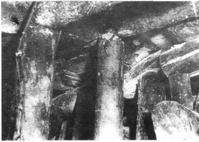
Крепление при разработке третьего свода.
