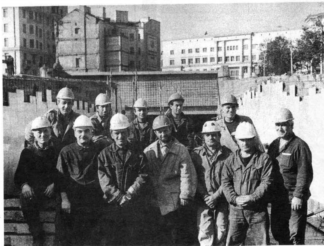
Монтажники участка № 4, сооружающие второй выход на станции «Маяковская». Бригадир Г. Шилакадзе (первый слева), начальник участка Г. Николаишвили (второй слева), механик участка А. Алания (крайний справа).
