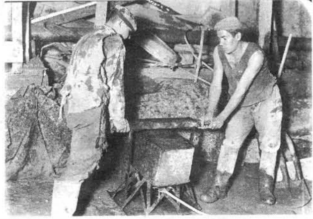
Уплотнение бетона с помощью вибратора.
