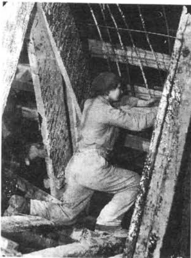
Армирование свода перед бетонированием.
