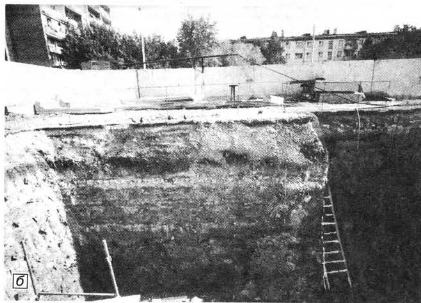
Фрагменты котлована, закреплённого стержневой крепью:
