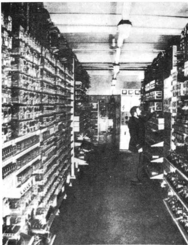
Электроподстанция I очереди.
