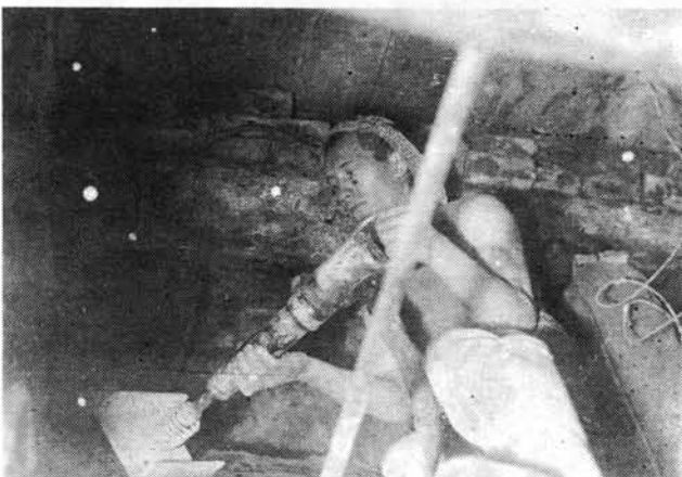
Уплотнение бетона пневматической трамбовкой.
