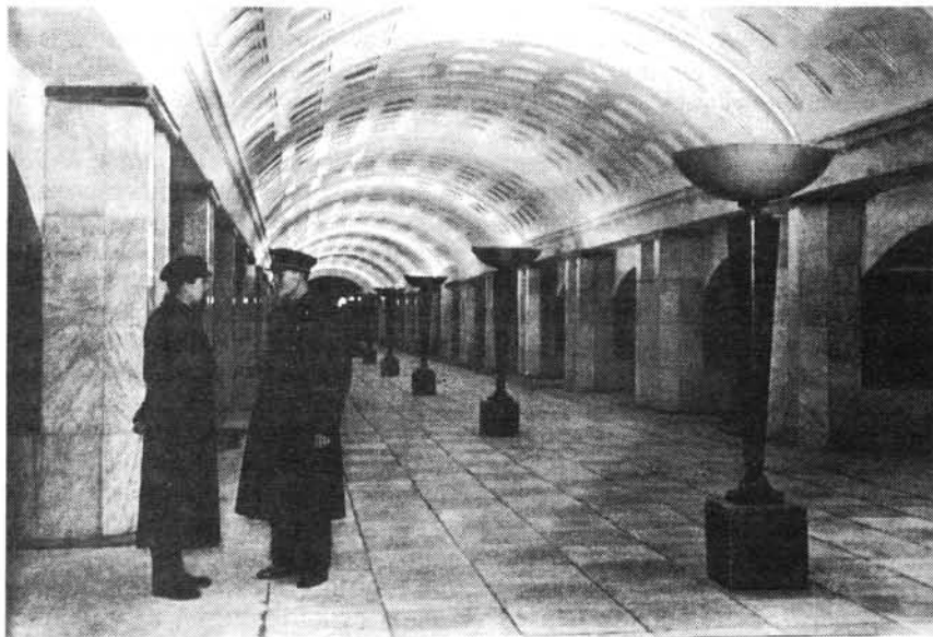
Москва. Станция метро „Охотный ряд“ Распределительный зал.
