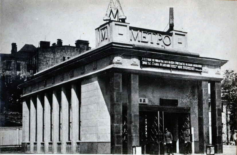
24. Ст. "Парк Культуры им. М. Горького." Вестибюль. . . Station "Park de Culture M. Gorky." Entrée.
